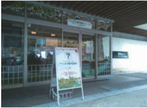
入口看板による案内
